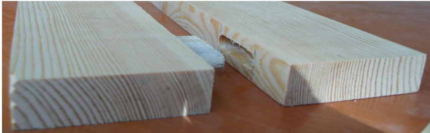
Resim 1.8: Yabancı zıvanalı en birleştirme
