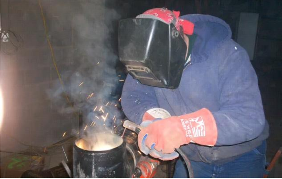
Resim 1.2: Elektrik ark boru kaynağı
