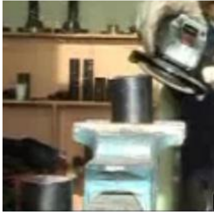
Resim 4.1: Boruya el taşlama ile kaynak ağızı açılması
