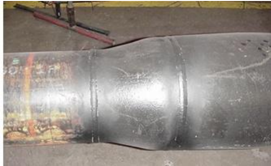
Şekil 2.27: Redüksiyon borusu kaynağı
