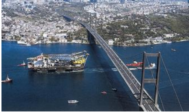
Resim 1.18: Fatih Sultan Mehmet Köprüsü
