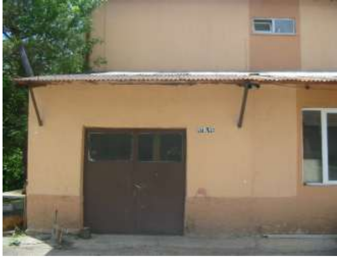
Resim 4.11: Bakım ve onarım atölyesi
