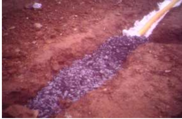
Resim 3.3: Arazi drenajının yapılması
