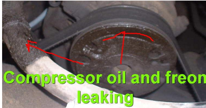
Resim 2.12: Soğutucu akışkan ve yağ kaçağının kavrama ve boru üzerindeki korozyif etkisi
