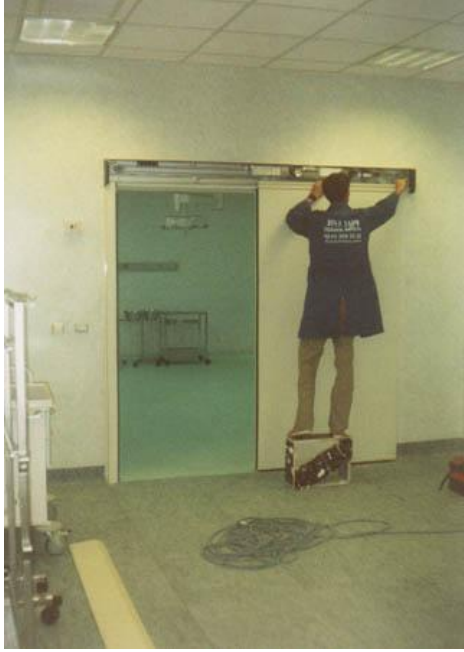
Resim 1.21: Kapı sürgü dişli kasağı montajı
