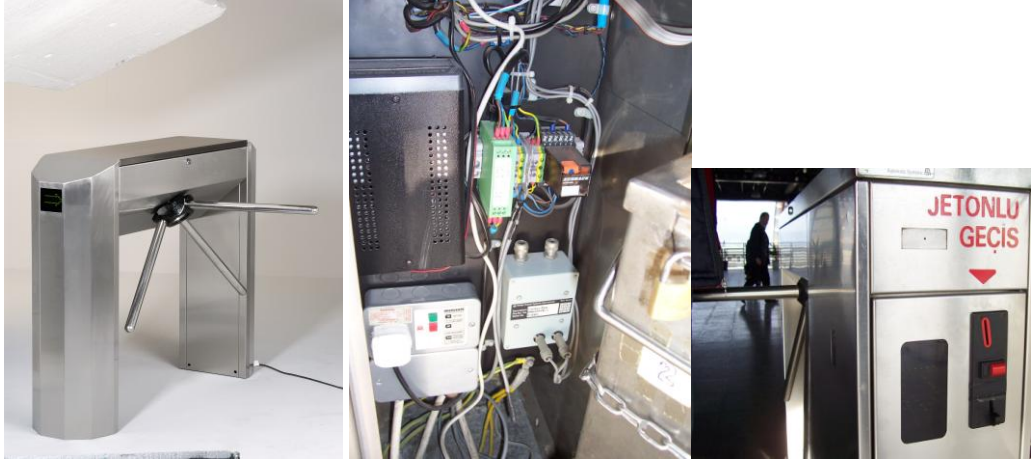
Resim 1.39: Jetonlu turnikeler ve iç yapısı
