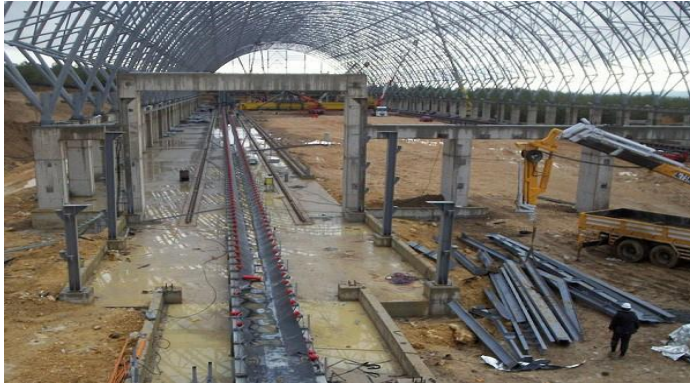
Resim 3.2: İnşaat hâlindeki bir fabrika
