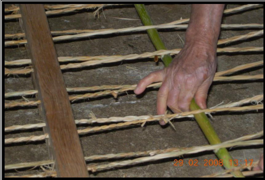
Resim 1.2: özgü iplerinin arasına kargı kamışı yerleřtirme
