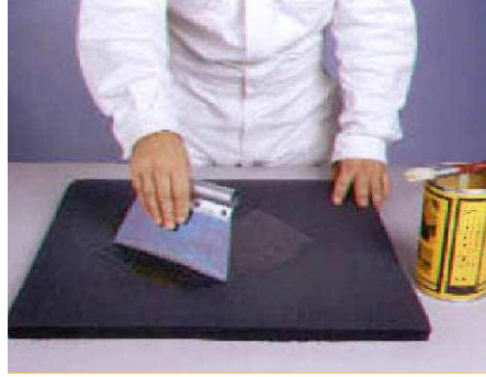
Resim1.21: Elastomerik kauçuk köpüğün kanala uygulanması
