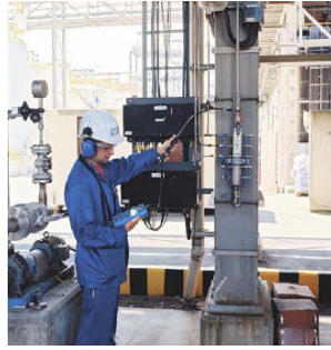
Resim 3.2: Havalandırma kanallarında gürültü ölçümü
