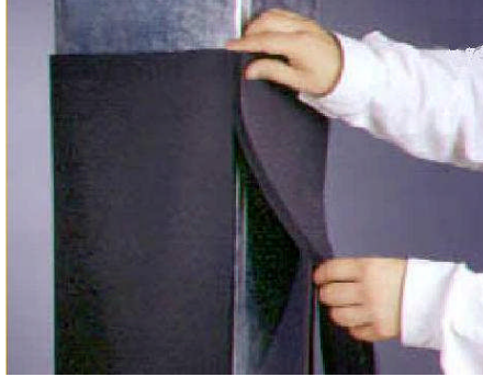
Resim1.20: Elastomerik kauçuk köpüğü yapıştırıcısının sürülmesi
