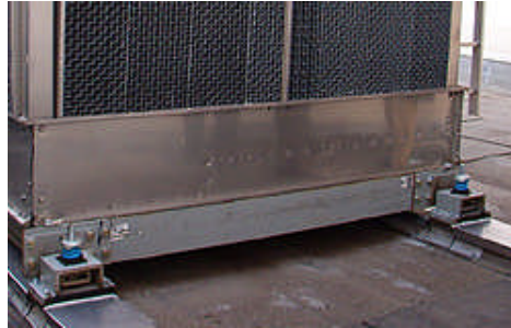
Resim 5.5: Soğutma kulesi zemin bağlantıları
