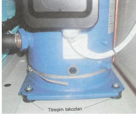
Resim 5.3: Kompresör titreşim takoz bağlantısı
