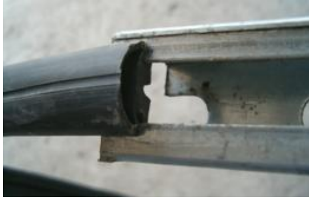
Resim 4.10: C profile contanın takılması
