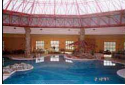
Resim 2.6: Perforce PVC hava kanalı uygulaması
