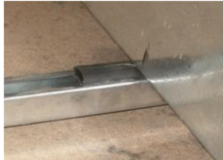
Resim 4.11: C profile conta takılmış hâlde kanalın profile basması
