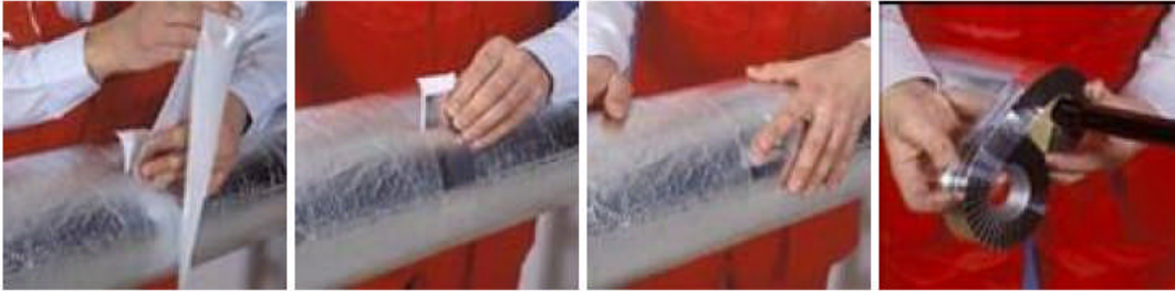
Resim 6.6: Borulara ısı yalıtım uygulanması
