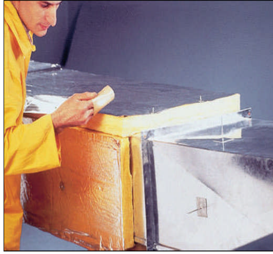
Resim 6.4: Cam yünü levhanın kanal üzerine uygulanışı
