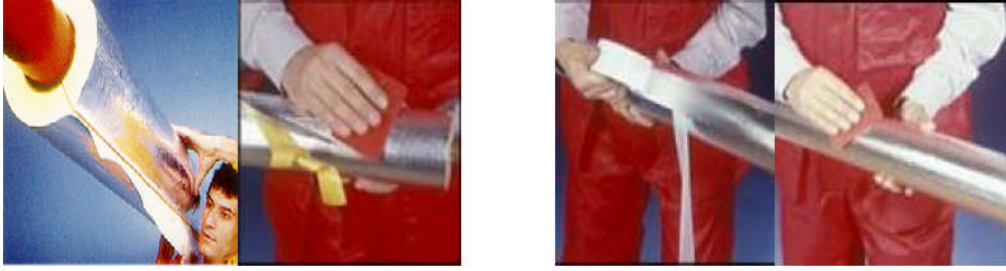
Resim 6.5: Borulara ısı yalıtım uygulanması
