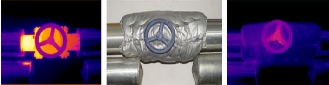
Resim 6.13: Havalandırma tesisatında kullanılan vanalarda yalıtım uygulaması
