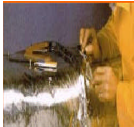
Resim 6.3: Tespit pimi ve klima şiltesinin kanal üzerine uygulanışı
