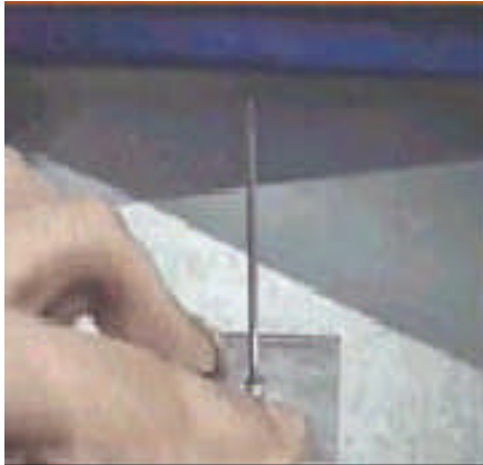
Resim 6.3: Tespit pimi ve klima şiltesinin kanal üzerine uygulanışı
