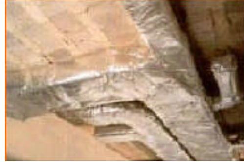
Resim 6.1: Klima şiltesi ve havalandırma kanalına uygulanmış görüntüsü
