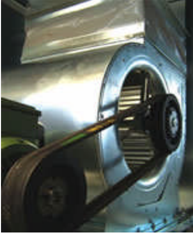
Resim 4.1: Fan ve motor bağlantısına bir örnek
