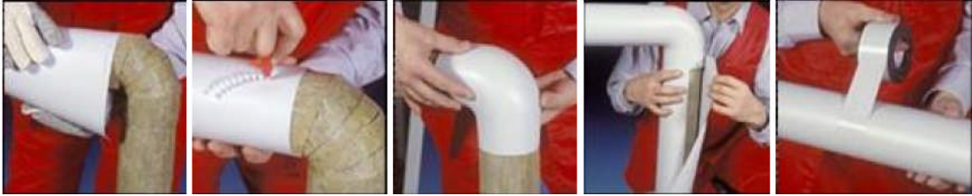
Resim 6.8: Borulara ısı yalıtım uygulanması
