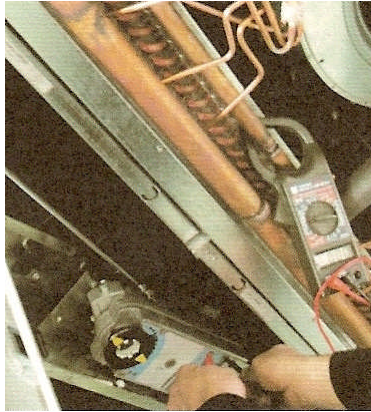
Resim 1.5: Pens ampermetre ile lm yapma
