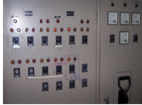
Resim.1,6: Merkezî iklimlendirme ve havalandırma santralının kumanda panolarının iç ve dış görünüşleri
