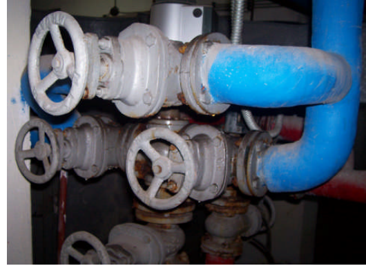
Resim4.15: Merkezi sistem tesisat devresi vana montajı
