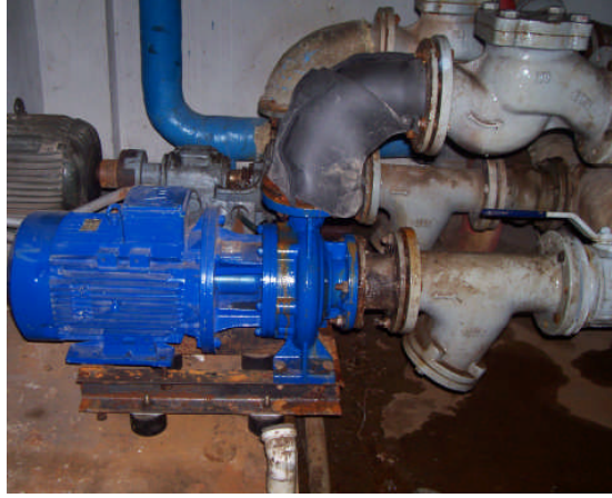
Resim4.28: Santrifüj pompanın tesisata montaj resmi
