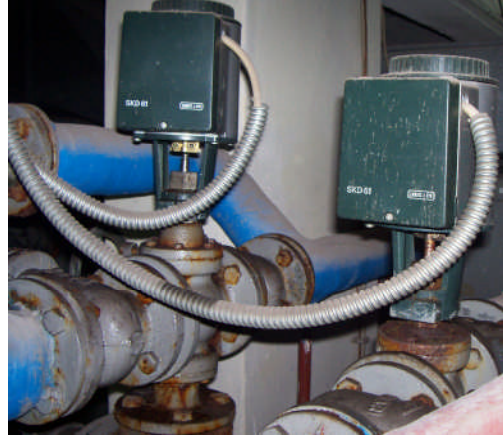
Resim 4.20: Merkezi sistem üç yollu vana montajı
