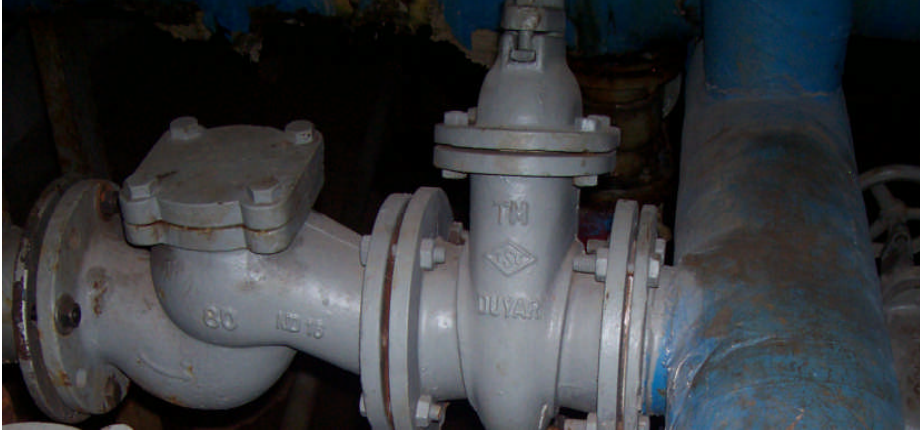
Dönüş kolektörü filtre vana montaj resmi
