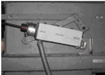
Resim 2.9: Yuvarlak ve Dikdörtgen hava damperlerine montajı yapılmış servomotorlar
