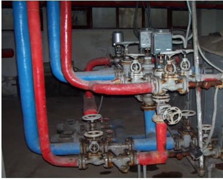
Resim4.14: Merkezi sistem tesisat devresi
