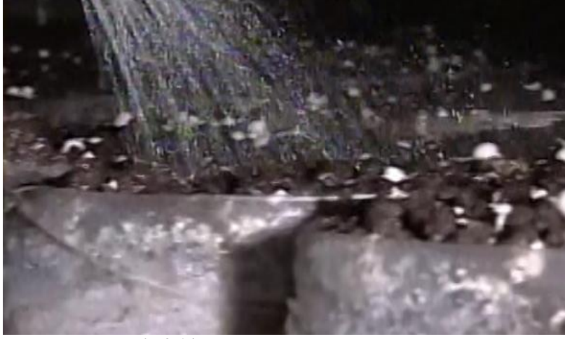
Resin 2.14: Mantarda sulamanın yapılması
