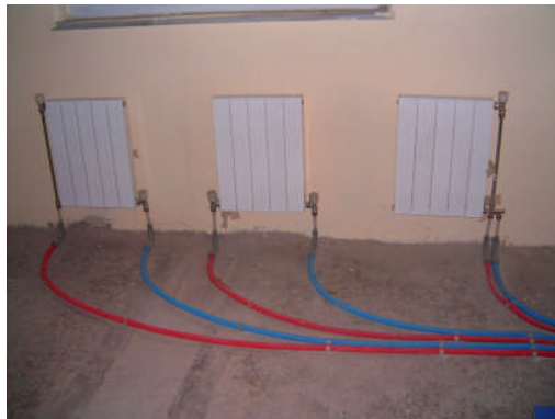
Resim 1.9: Boruların ısıtıcılara çekilmesi
