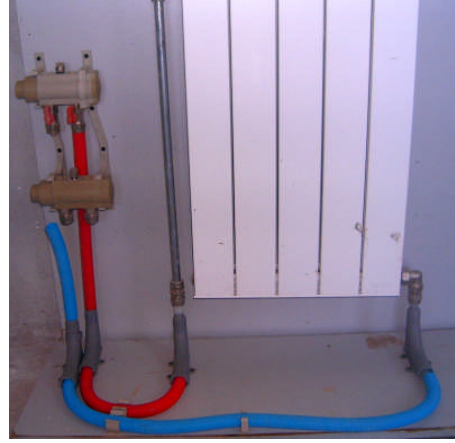
Şekil 1.6: Isıtıcının kolektöre bağlantısı
