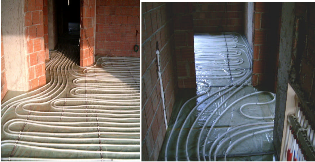
Resim 2.4: Isıtıcı boruların döşenmesi
