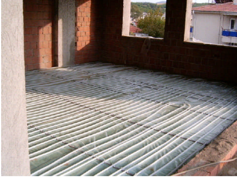
Resim 2.1: Yerden ısıtmanın yapılışı
