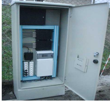
Resim 3.17: Kamera sisteminde kullanılan fiber optik sonlandırma panosu
