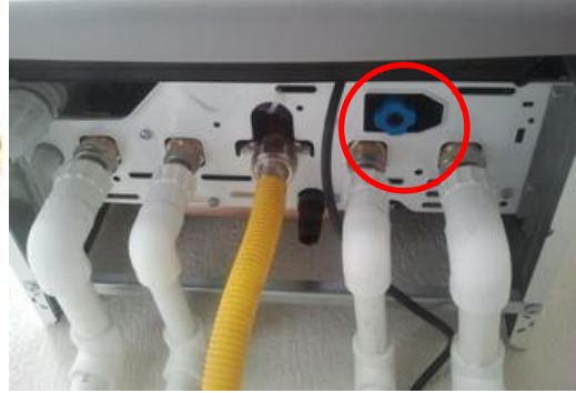
Resim 7.1: Kazan su doldurma vanası ve kombi su basma vanası
