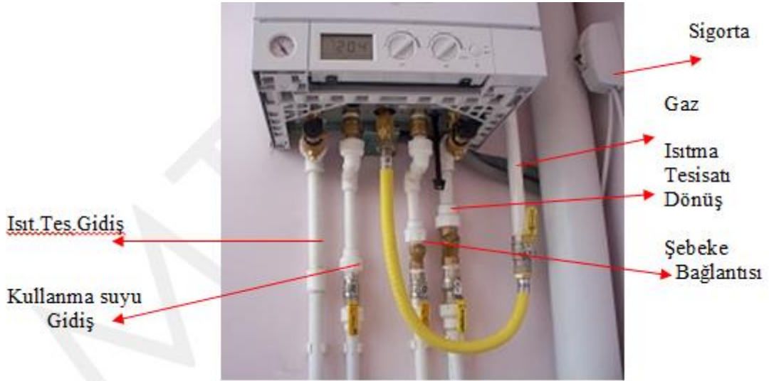
Resim 2.23: Kombi montaj seti bağlantısı
