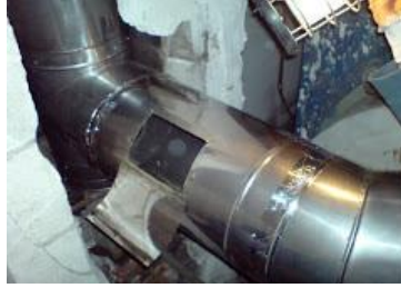
Resim 6.1: Baca temizleme kapağı
