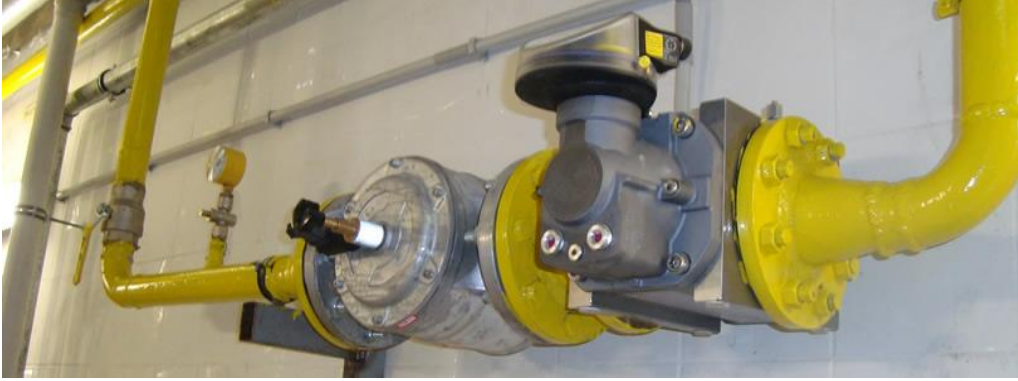
Resim 1.4: Rotary sayaç montajı
