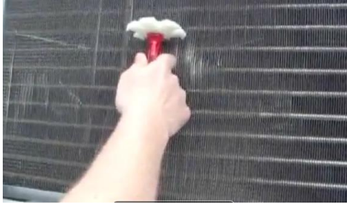
Resim.2.25.Kondenser temizliđi için fin tarađı
