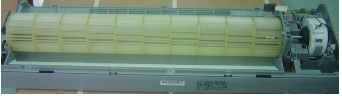
Resim.2.33: İç ünite fan kanatçıklarının temizlenmesi
