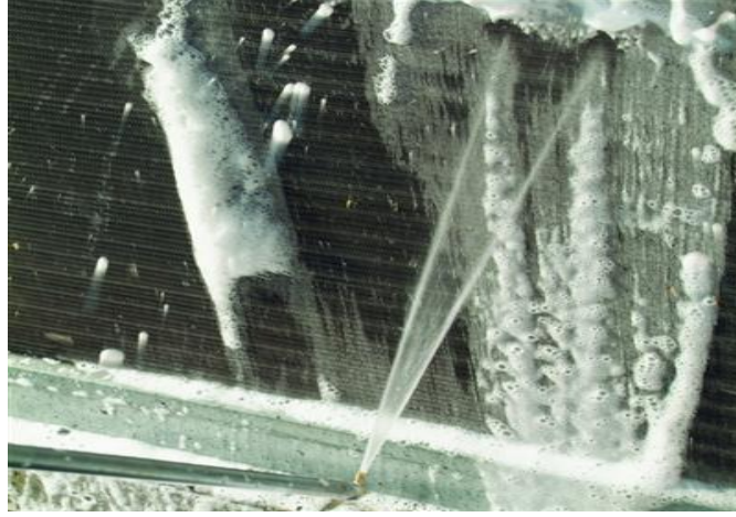
Resim.2.24.Kondenser su ve kimyasallarla ile temizliđi
