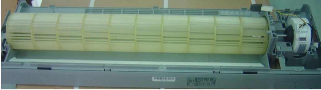
Resim.2.5: Fan motoru ve fan kanatların bakımı
