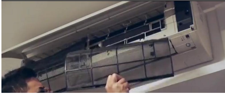
Resim.2.21.Hava filtresinin çıkarılması
