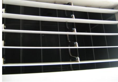
Resim.1.4: Hava yönlendirme kanatlarının ayarlanması
