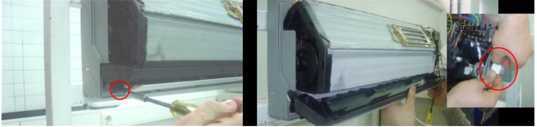
Resim.2.2:Hava yönlendirme kanalın sökülmesi
