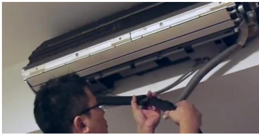
Resim.2.30: Drenaj tavası ve hortumunun elektrik süpürgesi ile temizlenmesi
