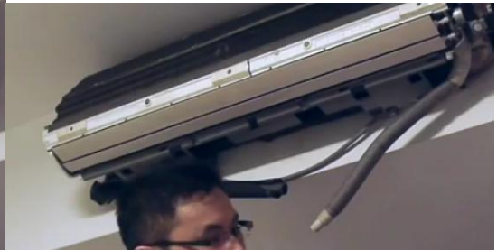
Resim.2.29: Drenaj tavası ve hortumunun temizlenmesi
