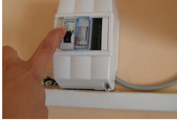
Resim.2.1: Sigortanın kapatılması
