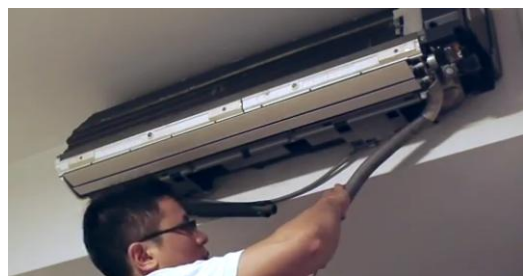
Resim.2.30: Drenaj tavası ve hortumunun elektrik süpürgesi ile temizlenmesi
