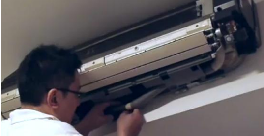
Resim.2.29: Drenaj tavası ve hortumunun temizlenmesi
