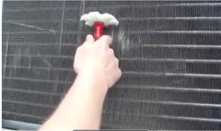
Resim.2.27: Kondenser Kanatçıklarının taraklanması
