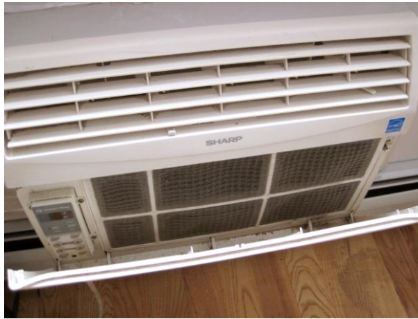
Resim 1.14: Klima panelinin açılması
