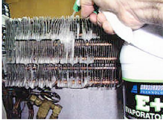
Resim 3.3: Uygun kimyasallar kullanılarak evaporatörün temizlenmesi
