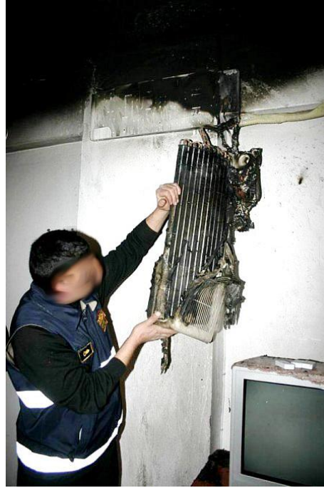
Resim 2.28: Kısa devre sonucu yanmış bir klima
