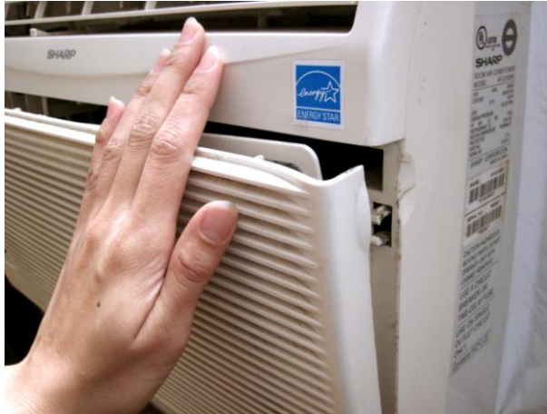
Resim 1.16: Klima panelinin kapatılması
