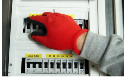
Resim 2.12: Beslemenin (sigortanın) kapatılması
