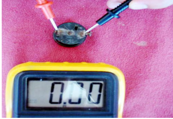
Resim 2.17: Termik kontaklarının kontrolü
