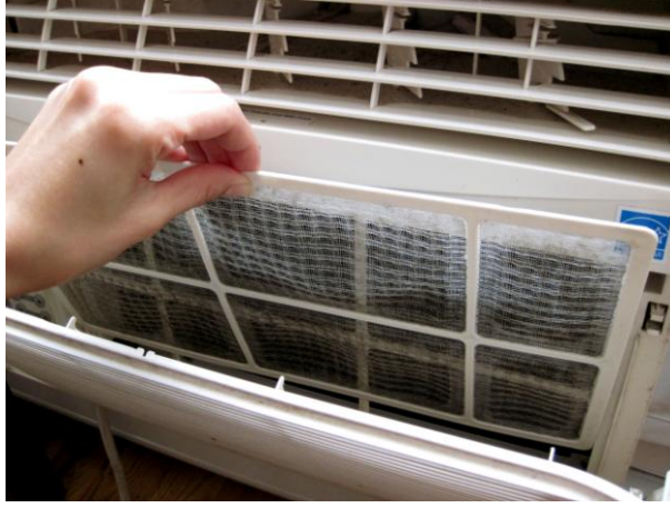
Resim 1.15: Filtrelerin çıkartılması
