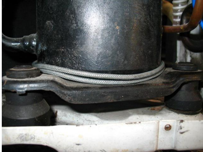
Resim 3.14: Kompresör karter ısıtıcısının montajı resmi
