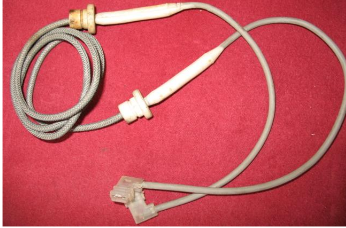
Resim 3.13: Kompresör karter rezistansı
