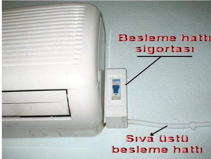
Resim 4.2: Besleme hattı çekilmiş klima cihazı
