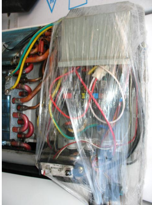
Resim 1.12: Bakım öncesi elektronik kartın korumaya alınması gerekir.
