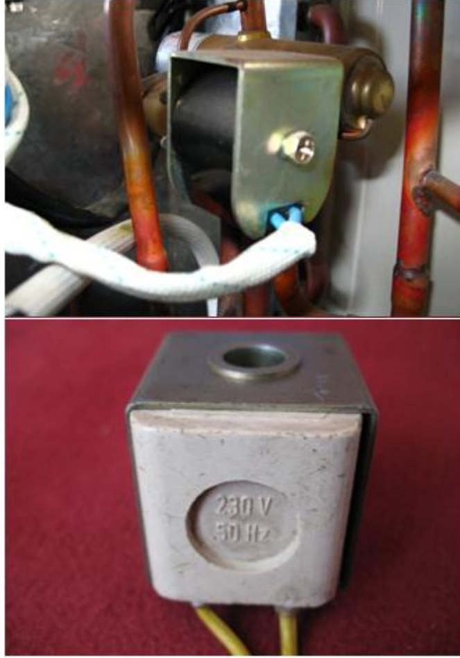
Resim 1.14: Solenoid bobinin montajlı ve montajsız gösterimi
