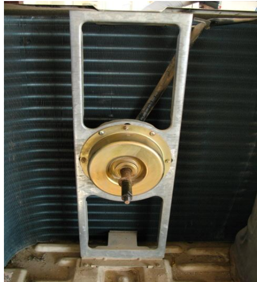
Resim 3.3: Dış üniteye montajlı haldeki dış ünite fan motorları
