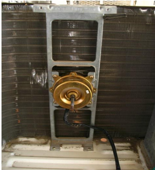
Resim 3.3: Dış üniteye montajlı haldeki dış ünite fan motorları
