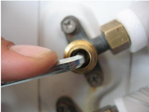
Resim 1.5: Sıvı ve gaz hattı valf kapaklarının açılıp anahtar kontrolünün yapılması
