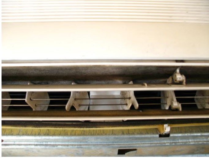
Resim4.2: Yatayda ve düşeyde havaya yön veren yönlendiriciler
