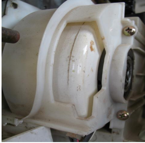
Resim 3.10: İç üniteye montajlı fan motoru
