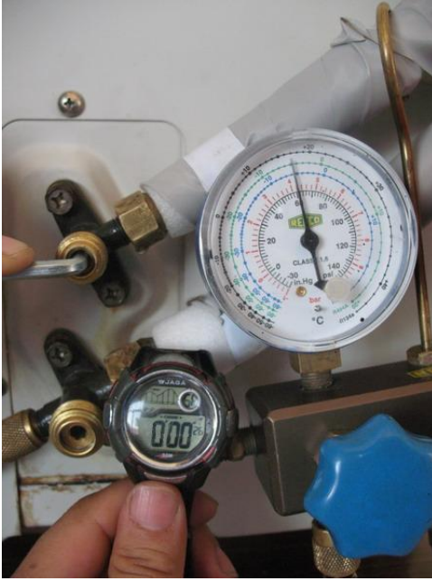
Resim 1.7: Sıvı hattının kapatılması
