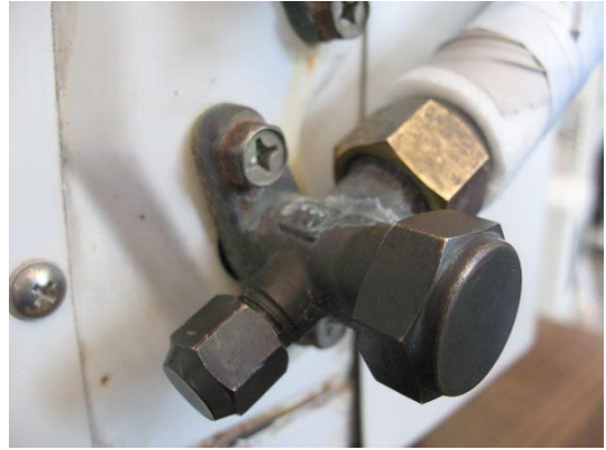
Resim 1.3: Üç yönlü gaz hattı valfi
