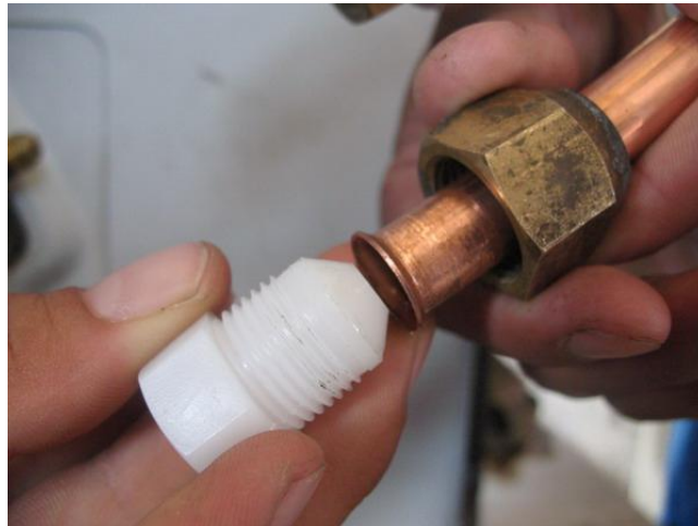
Resim 1.9: Boşta kalan bakır boru uçlarına kör tapa takılması
