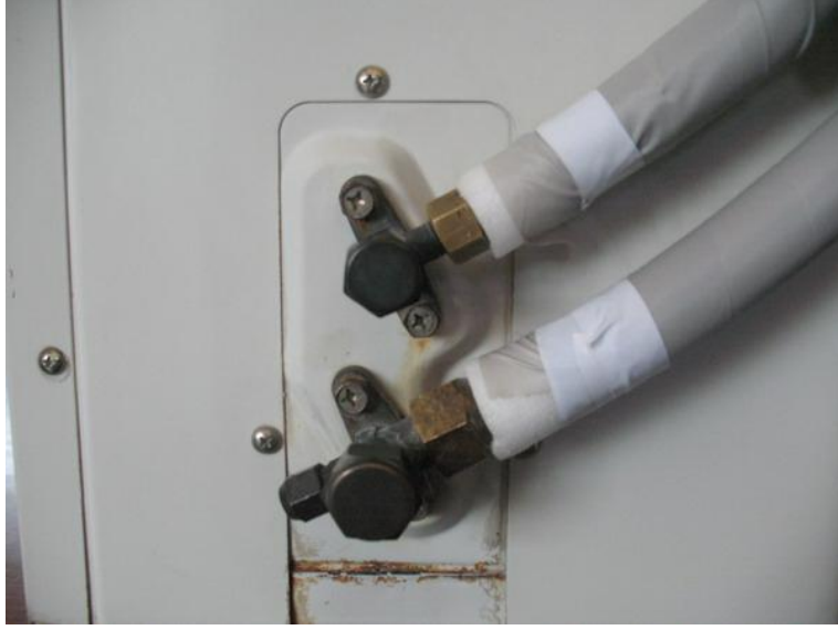
Resim 1.1: Dış üniteye montajlı servis valfleri
