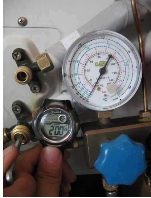
Resim 1.8: Gaz hattının kapatılması
