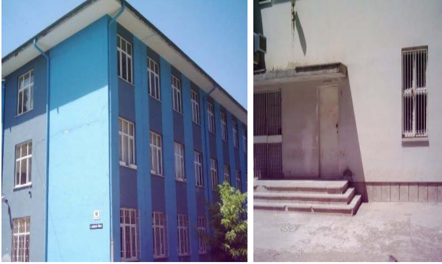
Resim 1: Cephe üzerindeki kapı ve pencereler
