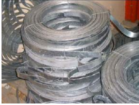
Resim 1.3: Galvaniz kaplı topraklama iletkeni
