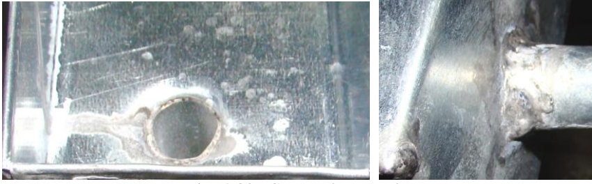
Resim 1.30: Sıvı geçiş yerlerinde
