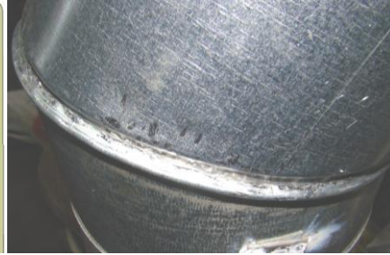
Resim 1.25: Boru birleştirmede lehim
