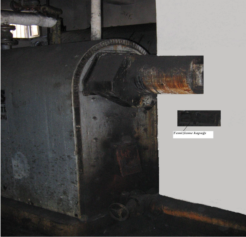
Resim 4.1: Baca alt kısmında bulunan temizleme kapağı yeri
