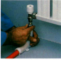
4. "Radyatör bağlantı seti" ile radyatöre bağlanır.
