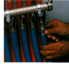
6. Kesilen uç "kolektör bağlantı seti" ile kolektöre bağlanır.
