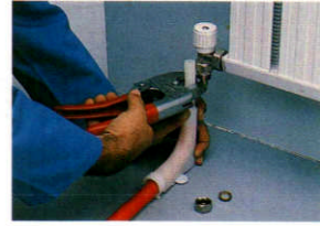
3. Köşe döndürücü ayaktan geçirilen boru radyatör bağlantı nipelî hizasından kesilir.
