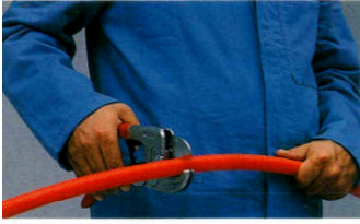
1. Boru özel makas ile dik olarak kesilir.
