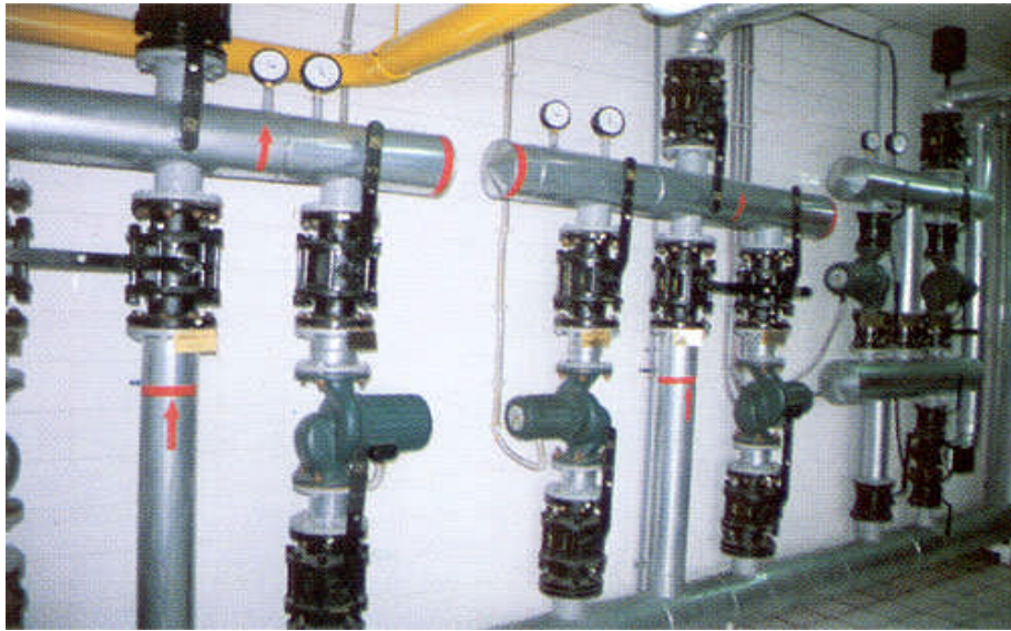
Resim1.20: Sirkülasyon pompasının tesisattaki yeri ve bağlantısı
