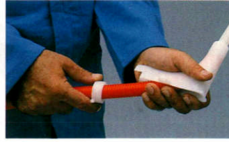
2. Kesilen boru köşe döndürücü ayak içinden geçirilir.
