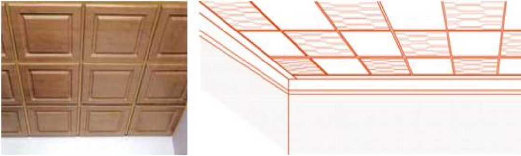
Resim 2.2: Plakalı tavan kaplaması ve çizimi
