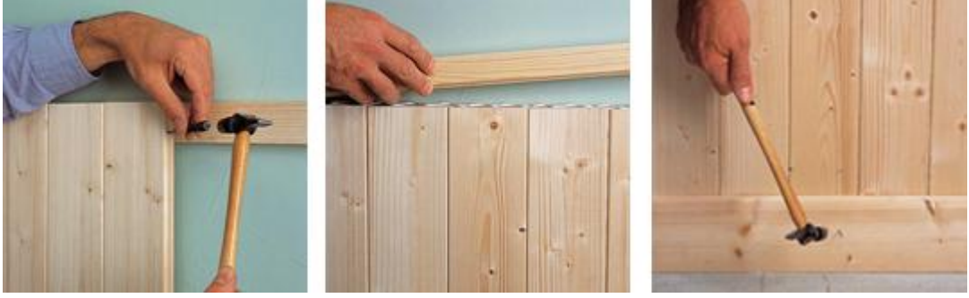
Resim 1.2: Duvar kaplamalarının ve süpürgeliklerin çakılması
