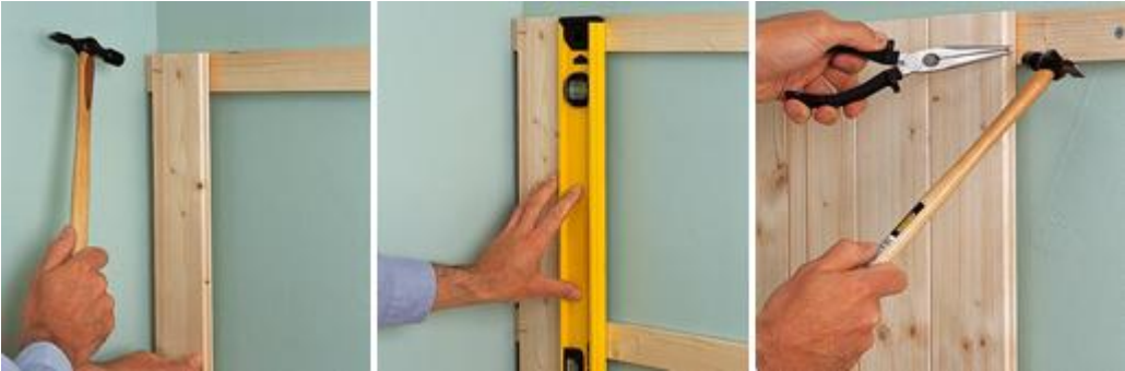
Resim 1.1: Duvar kaplamalarının duvara bağlanması ve alt konstrüksiyon
