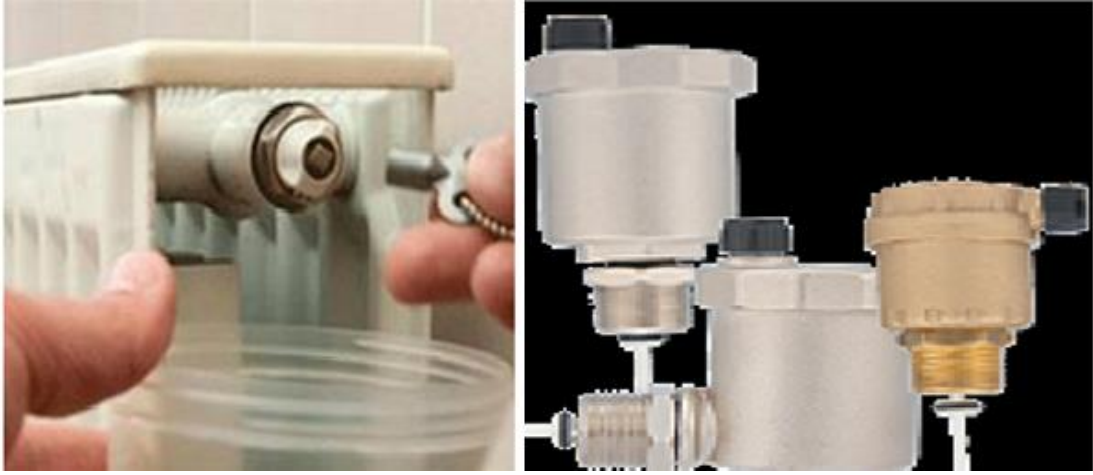
Resim 2.3: Radyatörün ve sistemin havasının alınması
