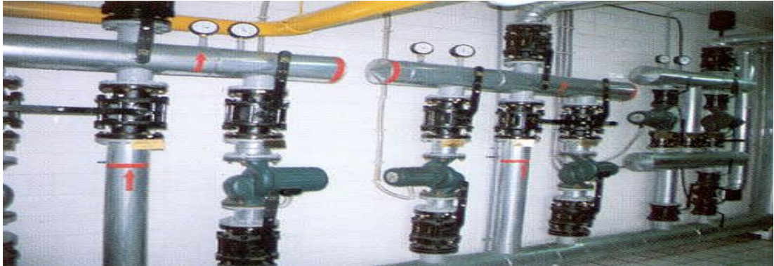
Resim 1.3: Sirkülasyon pompasının tesisattaki yeri ve bağlantısı
