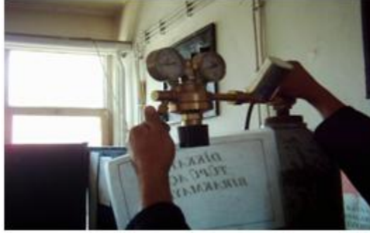
Resim 3.7: Gaz kaçakları için bağlantı kontrolünün yapılması
