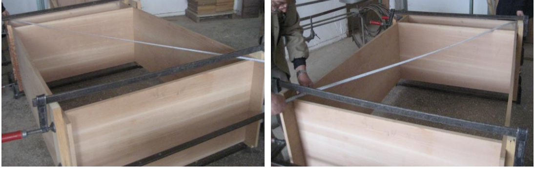
Resim 3.15: Birleştirilen işin gönye kontrolünün yapılması
