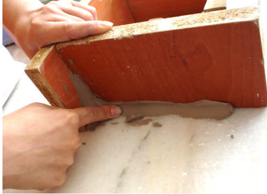
Resim 2.8: Alçı sızdırmazlıęını saęlama
