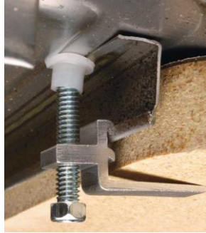
Şekil 1.19: Eviye tezgah montajı
