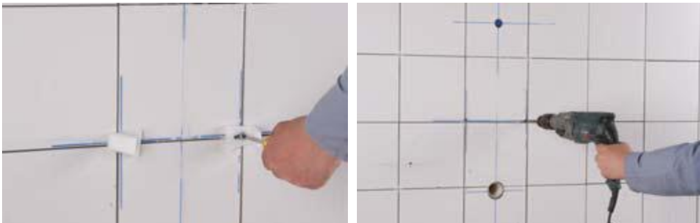
Şekil 4.16: Arkadan su girişli pisuvar L montaj parçasının sıkılması
