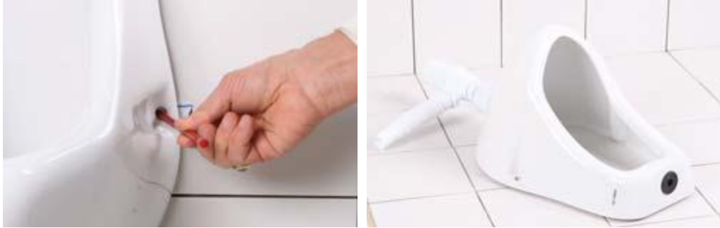
Şekil 4.11: Pisuvar montaj yerinin işaretlenmesi
