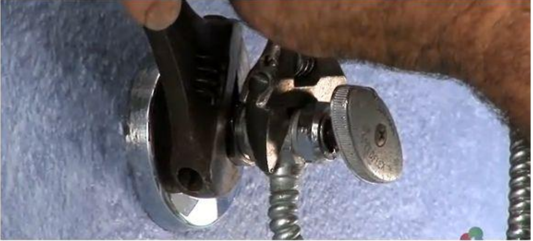
Resim 4.42: Ara musluk kurbađacak ile sıkılır.
