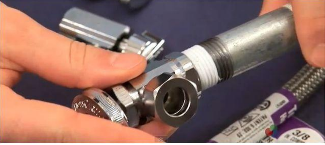
Resim 4.41: Teflon sarılmış ara musluk
