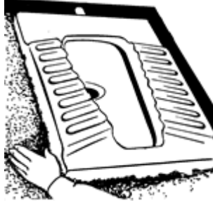
Resim 2.13 : Hela taşı altı kum ile doldurulması
