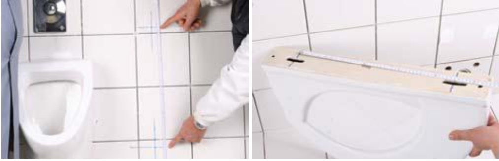
Şekil 4.24: Pisuvlar ara bölme montaj yerinin tespiti
