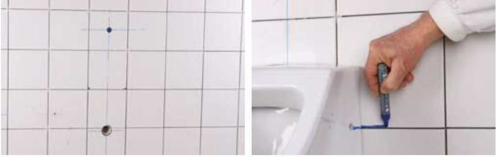
Şekil 4.19: Üstten su girişli pisuvar montaj teri tespiti
