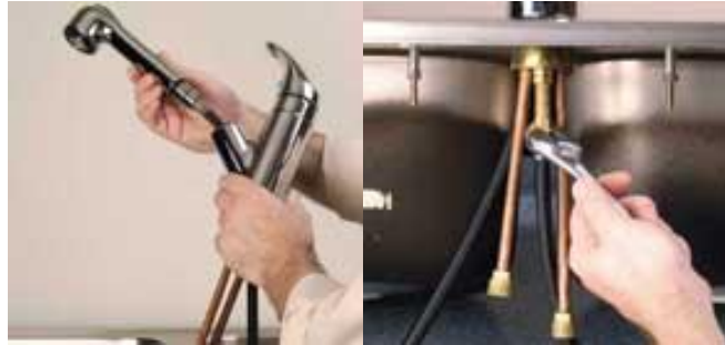
Şekil 1.16: Eviye batarya montajı
