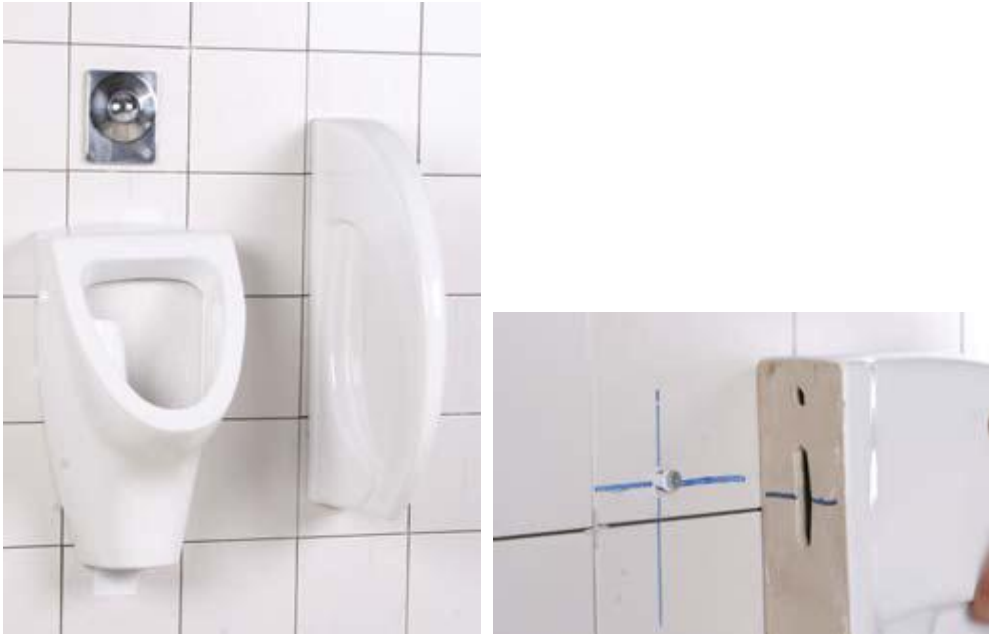
Şekil 4.25: Pisuvlar ara bölme montajı
