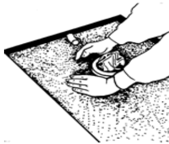
Resim 2.12: Sifon etrafının sabitlenmesi
