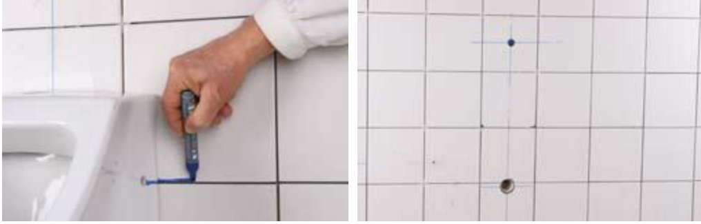
Şekil 4.14: Arkadan su girişli pisuvar montaj teri tespiti
