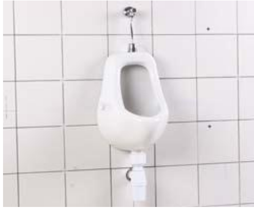
Şekil 4.13: Klasik Pisuvar yıkama borusunun bağlanması
