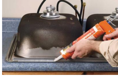
Şekil 1.17: Eviye alt kısmına silikon sürülmesi
