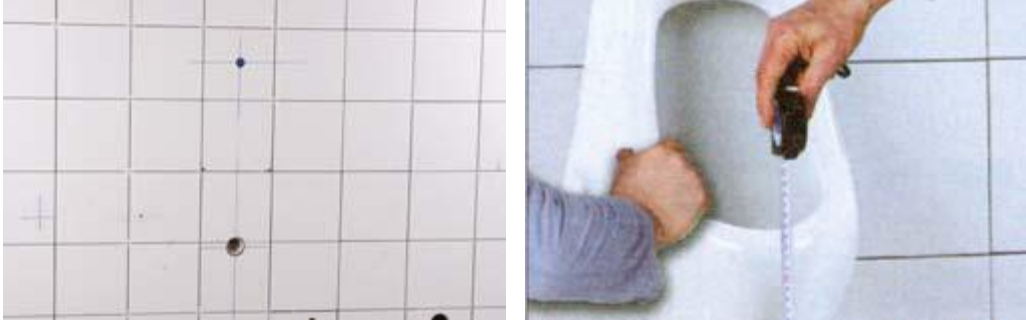
Şekil 4.10: Pisuvar montaj yerinin tespiti
