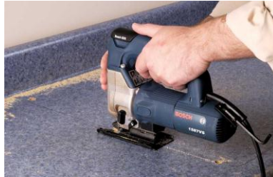
Şekil 1.15: Eviye yerinin kesilmesi
