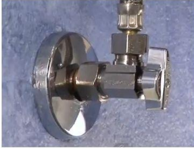
Resim 4.44: Montaj edilmiş ara musluk
