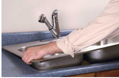
Şekil 1.18: Eviye alt kısmına silikon sürülmesi
