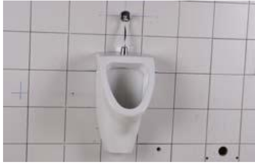
Şekil 4.23: Üstten su girişli pisuvar sifon ve duvara sabitlenmesi
