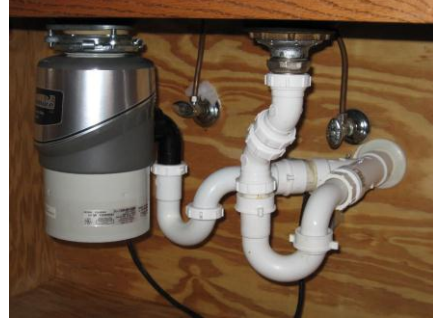
Şekil 1.30: Öğütücünün kirli suya bağlanması
