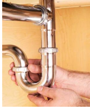
Şekil 1.20: Eviye sifon montajı
