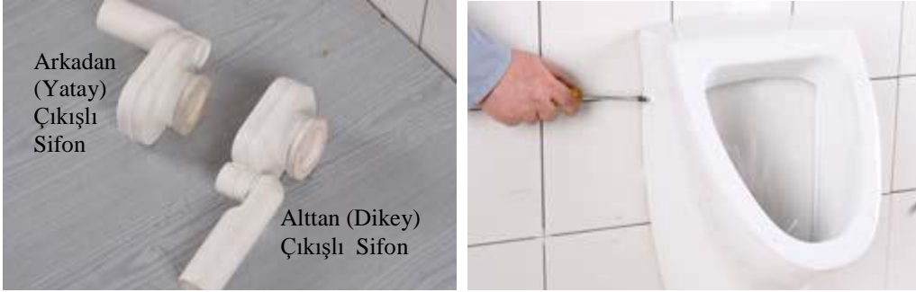
Şekil 4.22: Üstten su girişli pisuvar sifon ve duvara sabitlenmesi
