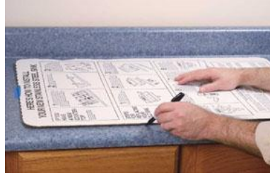
Şekil 1.14: Eviye Şablonunun işaretlenmesi
