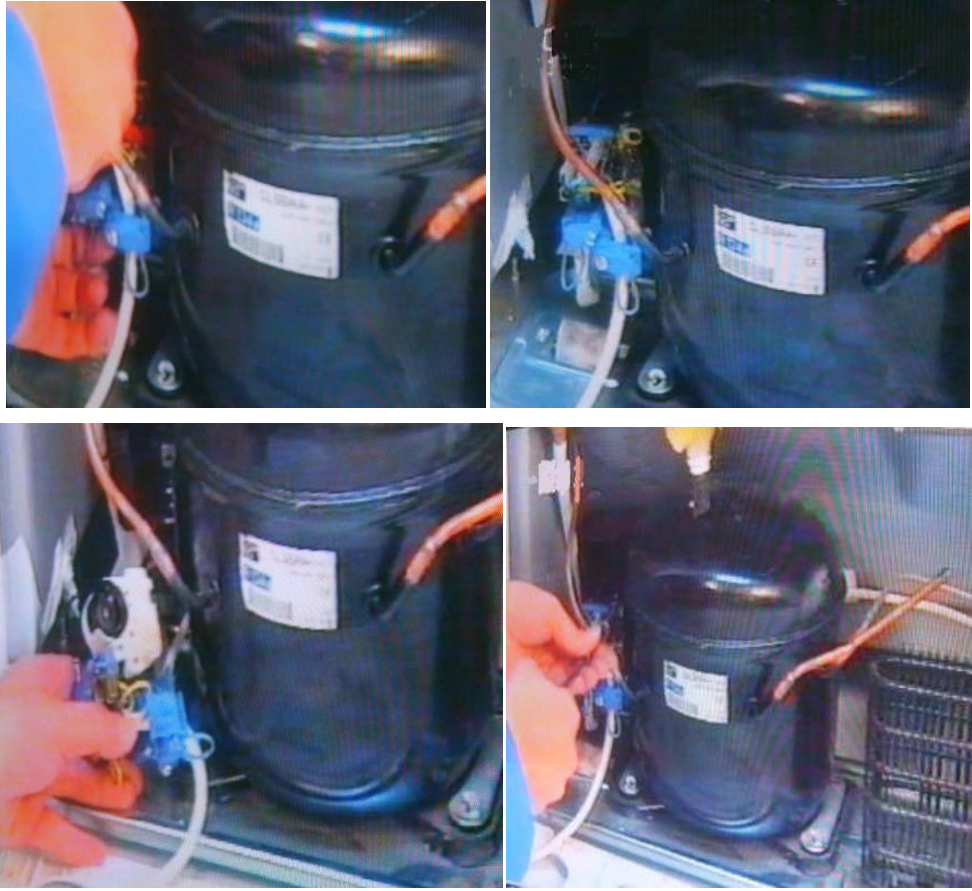
Resim 1.7: Rölenin sökülmesi
