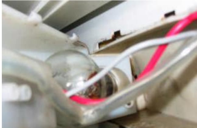
Resim 6.10: Lamba ve duy bölgesinin sökülmesi
