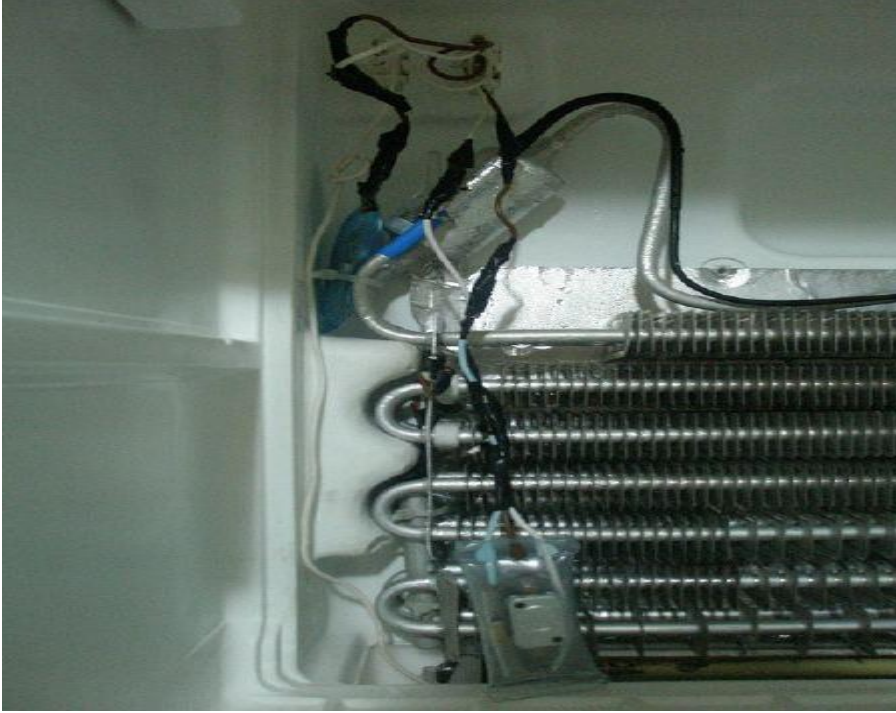
Resim 5.6: Termostop / termik sigortanın evaporatör üzerine bağlantısı
