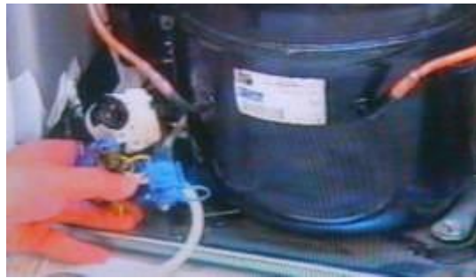
Resim 1.5: Termiğin monte edilmesi
