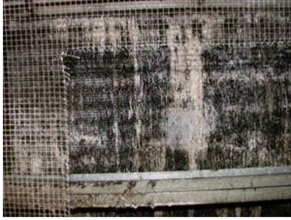
Resim 3.2: Kirlenmiş evaporatör
