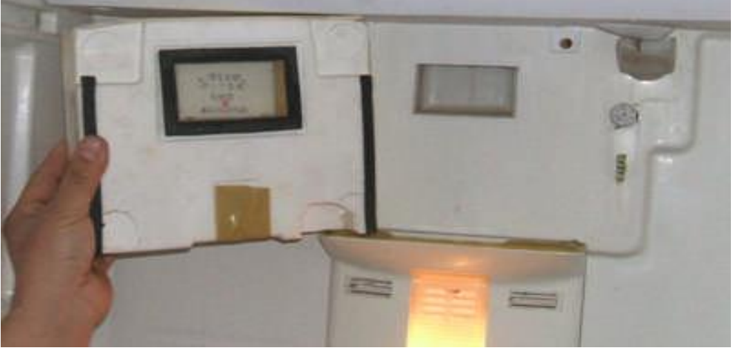
Resim 5.2: Damper termostatının montajı
