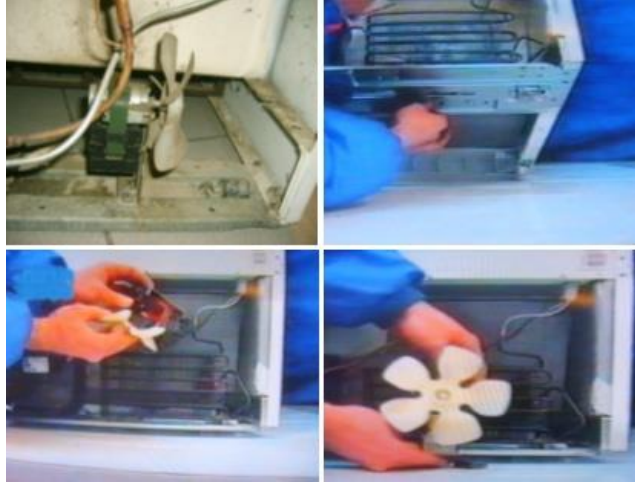
Resim 2.4: Kondenser fanının yerinden sklmesi
