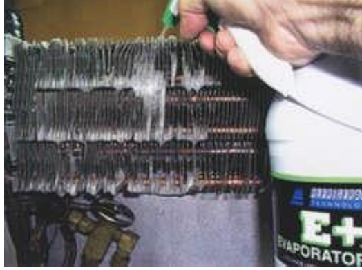
Resim 3.3: Evaporatörün uygun kimyasal ile temizlenmesi
