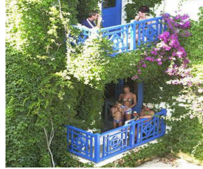
Resim 6.3. Boyalı demir balkon korkuluğu
