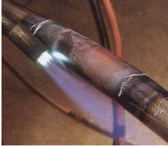
Resim 7.2: Pürmüzle borunun ısıtılması
