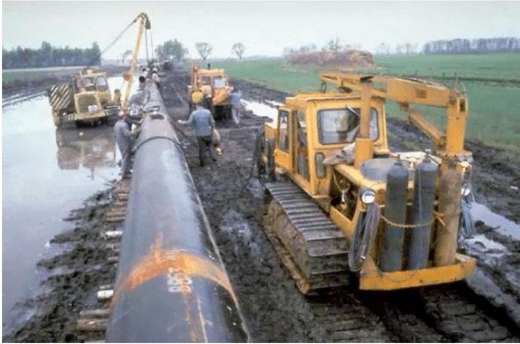
Resim 6.3: Boru hattında çalışma
