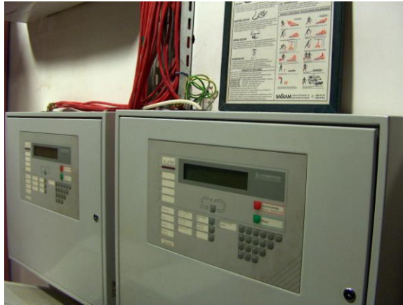
Resim 1.9: Yangın Alarm Sistemi
