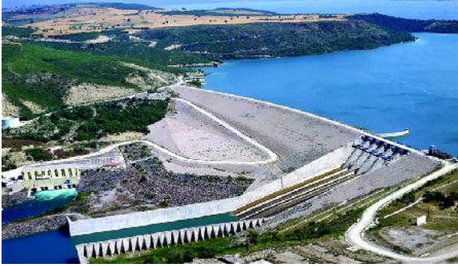
Resim 2.21: Aslantaş barajından su temini
