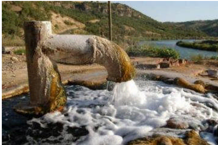
Resim 2.20: Yer altı suyu ünitesi
