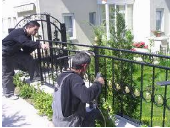
Resim 3.1: Bahçe parmaklık montajı
