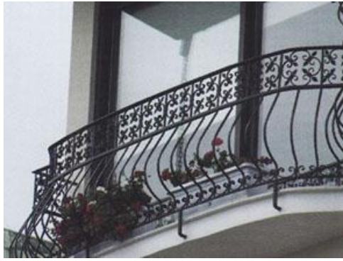
Resim 3.2: Balkon yan zemine monte edilmiş balkon parmaklığı
