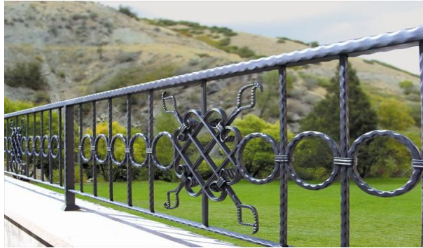
Resim 2.3: Kaynaklı ve bilezikli birleştirmeler ile yapılmış bahçe parmaklığı
