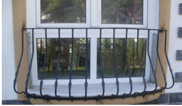
Resim 1.6: Kaynaklı birleştirme ile montajı yapılmış parmaklık
