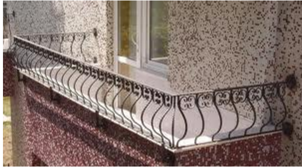
Resim 3.3: Balkon üst zemine monte edilmiş balkon parmaklığı
