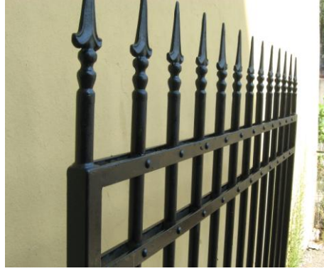
Resim 2.4: Kaynaklı ve perçinli birleřtirmeler ile yapılmıř bahçe parmaklıđı
