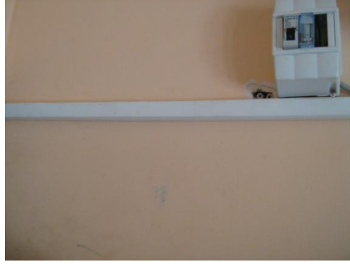
Resim 2.8: Buattan kablo kanalı içerisine sigortanın tespiti
