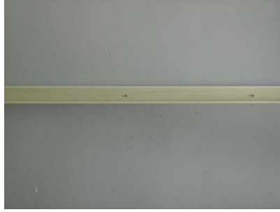
Resim 2.5: Kablo kanalı tespiti
