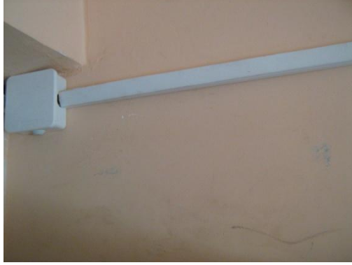
Resim 2.7: Buattan kablo kanalı içerisine kablonun tespiti Buattan gelen kablo sigortaya bağlanarak klima cihazına bağlantı yapılır.
