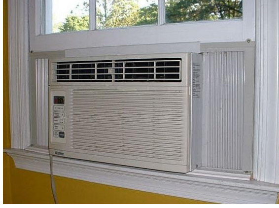
Resim 1.10: Pencere tipi montajında boşlukların kapatılması
