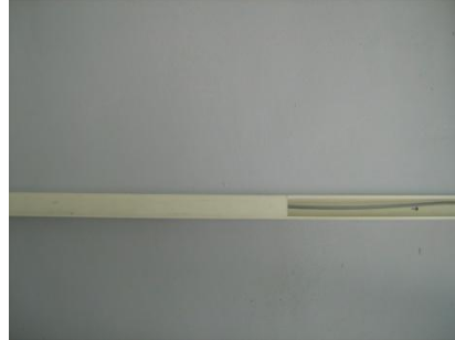
Resim 2.6: Kablo kanalı içerisine kablunun tespiti
