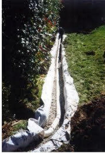
Resim 2.7: Drenaj sistemlerinin kuruluşu
