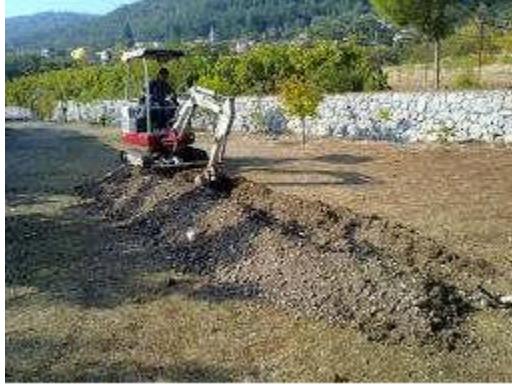
Resim 2.6: Peyzajda toprak altı sulama yönteminin kuruluşu
