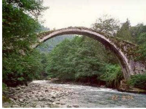
Resim 1.9: Doğa ile köprünün uyumu
