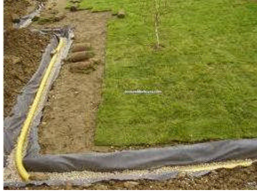
Resim 2.8: Drenajın kurulması
