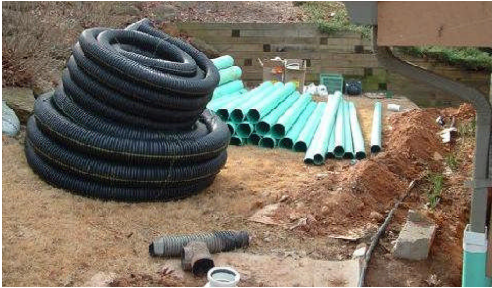
Resim 1.7: Drenaj borularının hazırlanması
