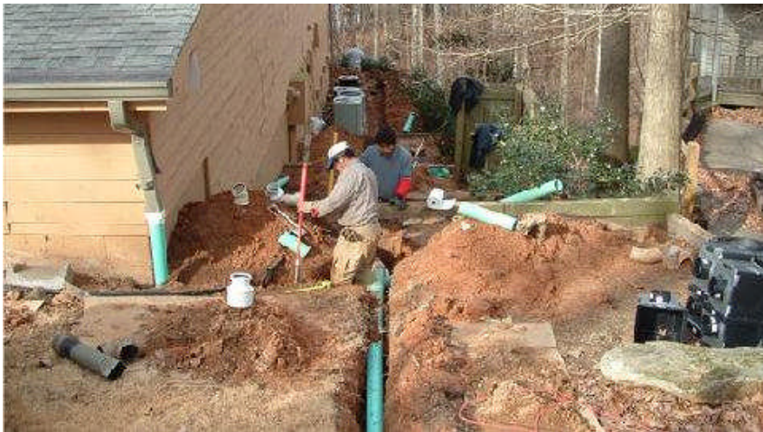
Resim 1.6: Peyzaj alanına drenaj borularının döşenmesi
