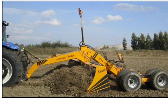
Resim 3.1: Peyzaj alanında kazı çalışması
