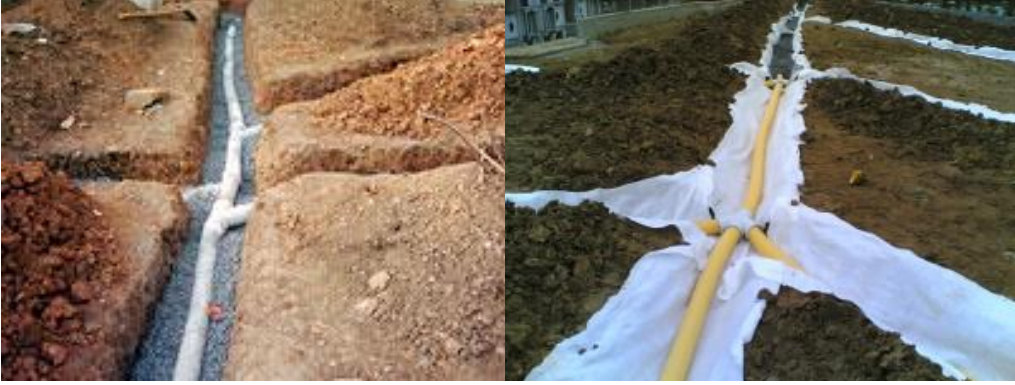
Fotograf 3.23: Drenaj borularının döşenmesi
