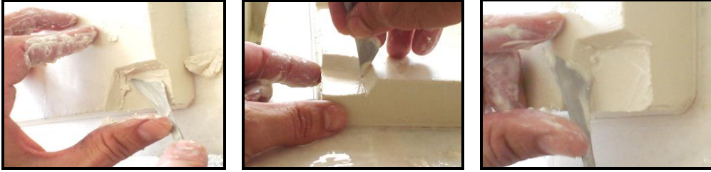
Resim5.6: Alçı plaka köşesinde köşeli pim açma aşamaları
