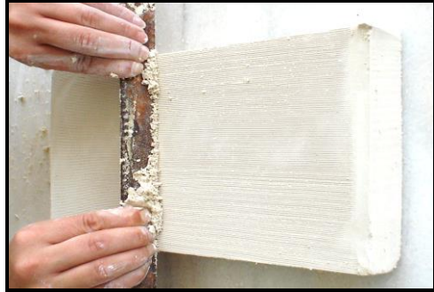
Resim4.12: Testere ile yüzeyi düzeltme
