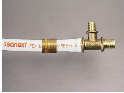
Resim 4.26: Bağlantı parçasının yerleştirilmesi
