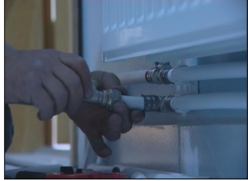
Resim 4.62: Rakorun sıkılması
