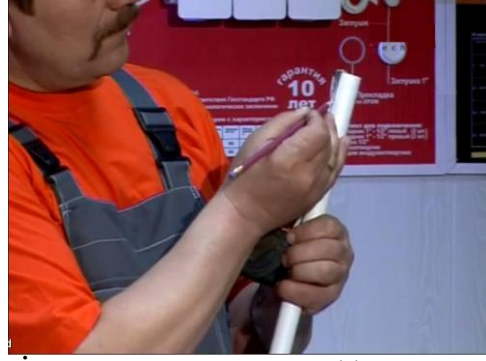
İşaretlenen yerden boru kesilir.
