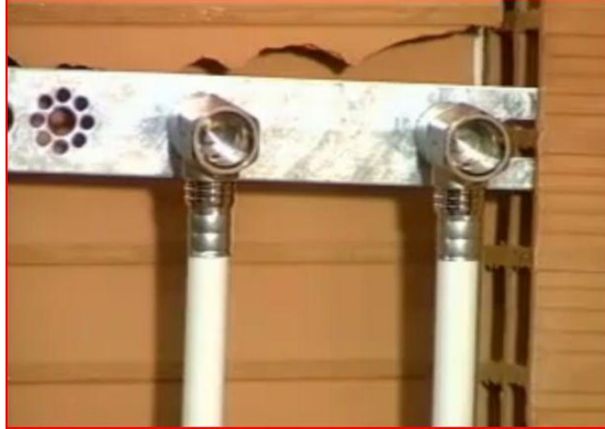
Resim 4.44: Birleştirme işleminin tamamlanması
