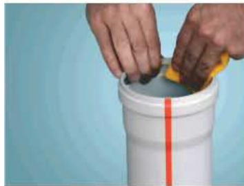
Resim 5.6: Boru ağzının temizlenmesi
