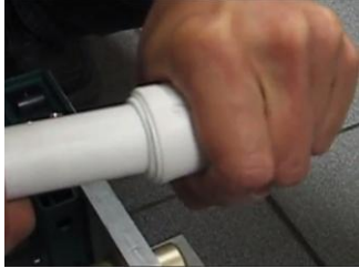
Resim 2.16: Polipropilen cam elyaf takviyeli boruların birleřtirilmesi
