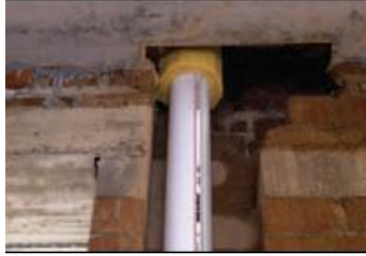
Resim 5.22: PVC boruların duvar geçişi
