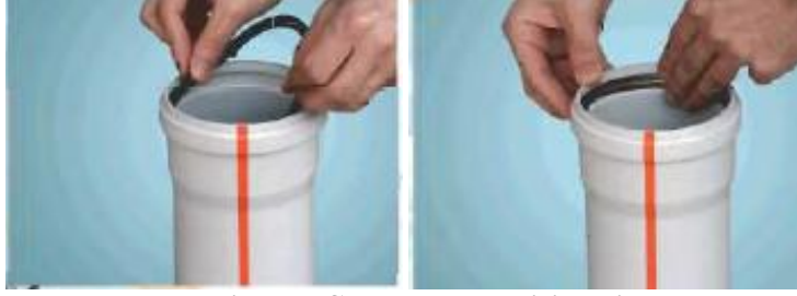
Resim 5.7: Contanın yerleştirilmesi
