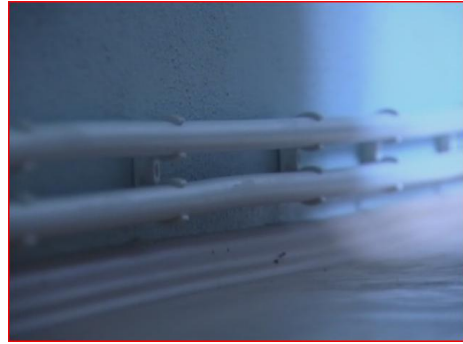
Resim 4.46: Kelepçelerin takılması
