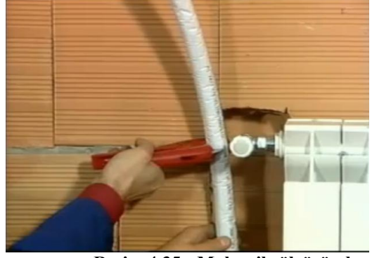
Resim 4.35: Makas ile ölçüsünde kesilmesi
