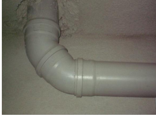
Resim 5.21: Kolon altında iki açık dirsek kullanımı
