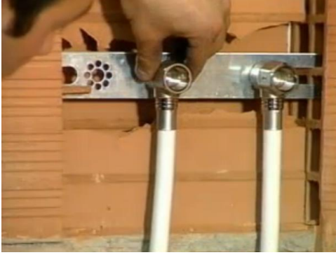
Resim 4.42: Birleştirme parçasının oturtulması
