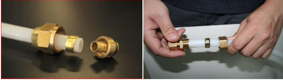
Resim 3.36: Baskı yüzüğünün boruya yerleştirilmesi
