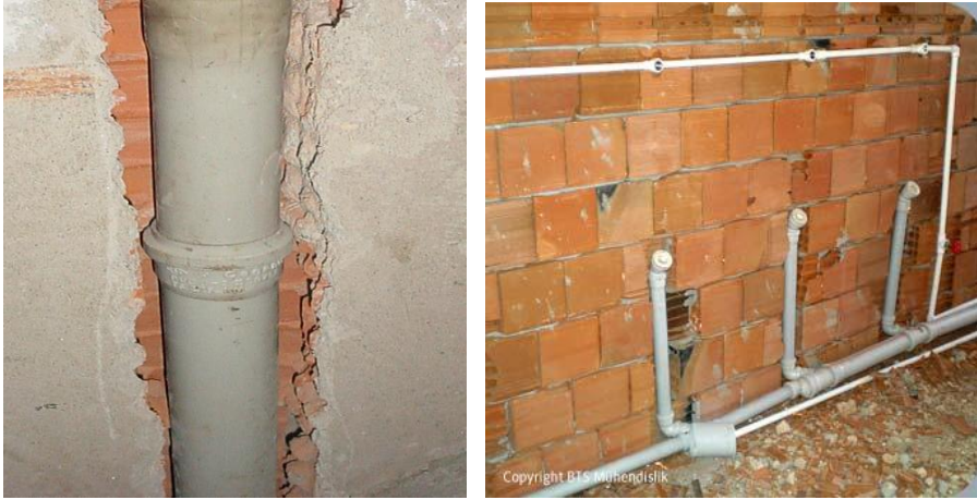
Resim 5.26: Kanal içerisine yerleştirilen boru
