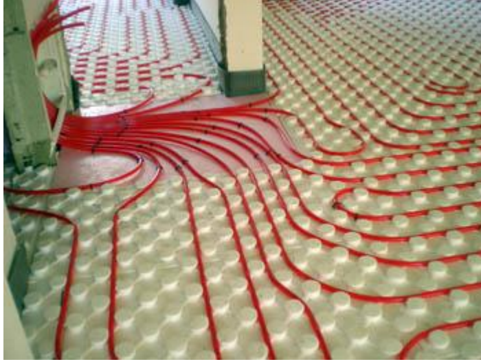
Resim 3.46: Yerden Isıtma sistemindeki uygulama
