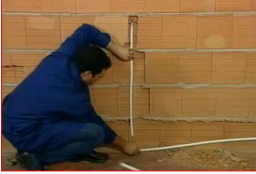
Resim 4.41: Kılavuz ile boru ağzın ayarlanması
