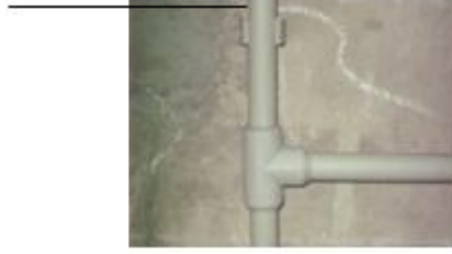
Resim 2.22: PP borunun plastik kelepçe ile sabitlenmesi
