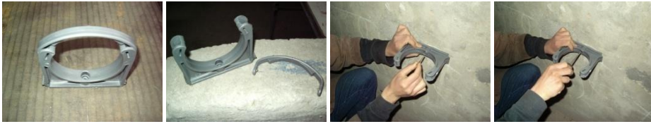
Resim 5.30: Plastik kelepçenin duvara sabitlenmesi
