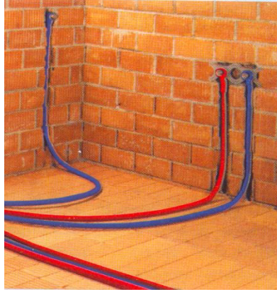
Resim 3.51: Kanal içerisinde PEX boru
