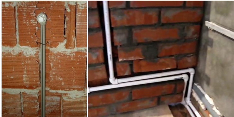
Resim 2.6: Kanal içinde PP boru
