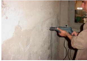
Resim 5.28: Matkap ile delik açma
