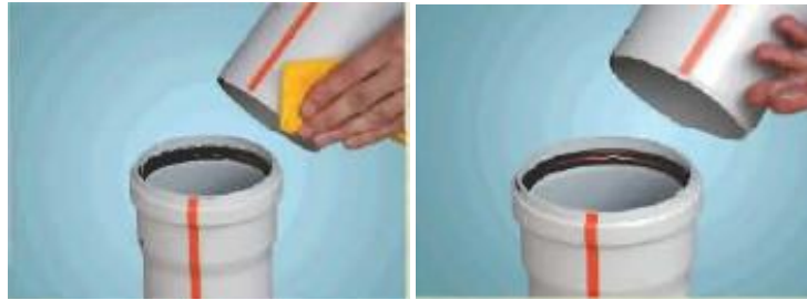
Resim 5.9: Kayganlaştırıcı sürülmesi ve montaj
