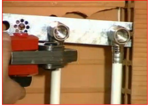
Resim 4.43: Presle sıkılması
