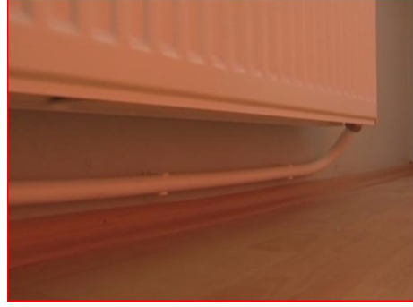
Resim 4.48: Düz hatların kelepçelenmesi
