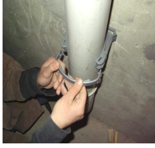
Resim 5.31: PVC borunun plastik kelepçe ile sabitlenmesi
