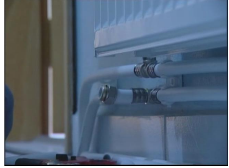
Resim 4.59: Borunun ölçüye göre kesilmesi Resim 4.60: Yüzük ve rakorun boruya oturtulması
