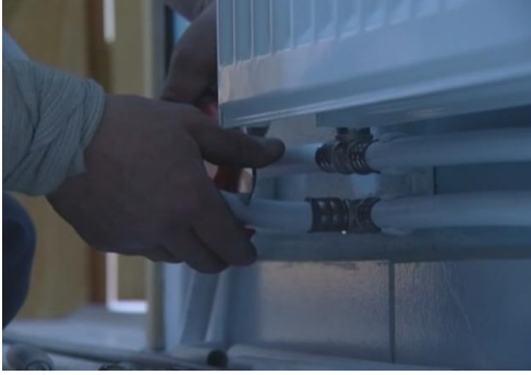
Resim 4.59: Borunun ölçüye göre kesilmesi Resim 4.60: Yüzük ve rakorun boruya oturtulması
