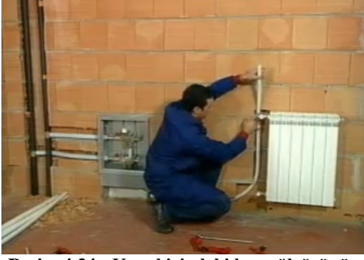
Resim 4.34: Kanal içindeki boru ölçüsünün alınması
