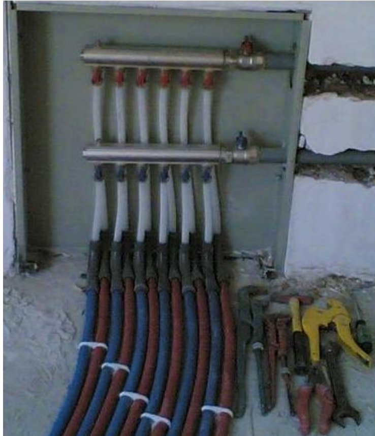
Resim 3.47: Yerden ısıtma sisteminde kolektör uygulaması
