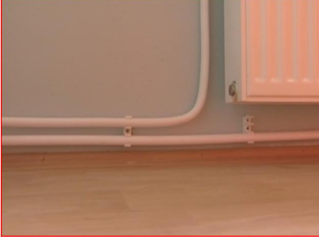
Resim 4.47: Düz hatların kelepçelenmesi
