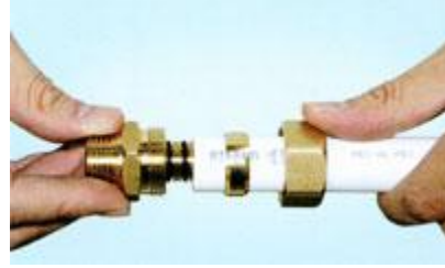
Resim 4.32: Yüzük ve rakor O-ring zarar vermeden yerleştirilmesi
