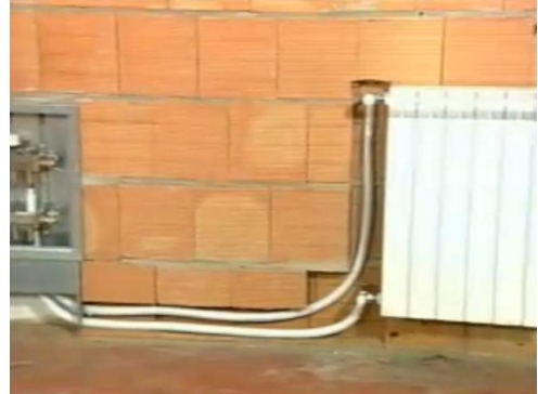
Resim 4.39: Kanal içine sabitlenmesi
