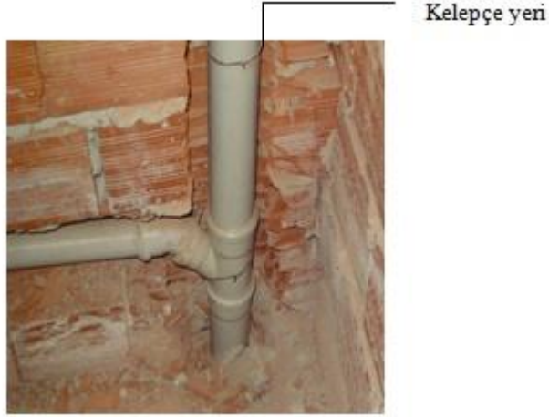
Resim 5.27: Yatay dikey boruların tespiti
