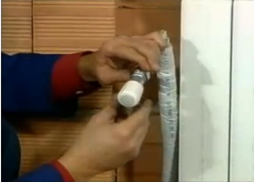
Resim 4.38: Rakorun sıkılması
