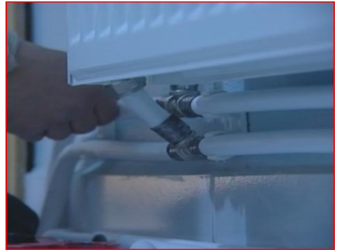
Resim 4.64: Bağlantı rakorunun sıkılması
