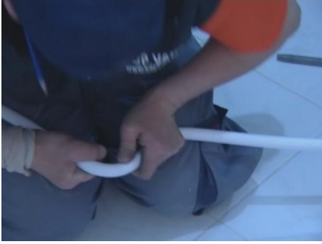
Resim 4.49: Dönüş dirseklerinin hazırlanması
