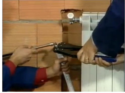
Resim 4.37: Parçanın preslenmesi
