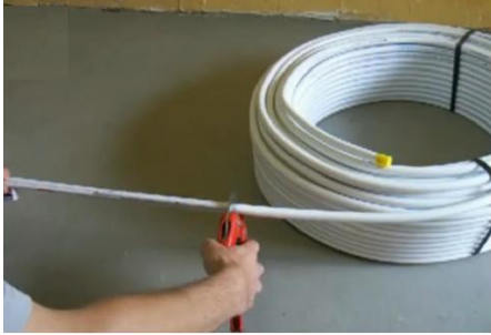
Resim 4.50: Ölçüsünde kesilmesi
