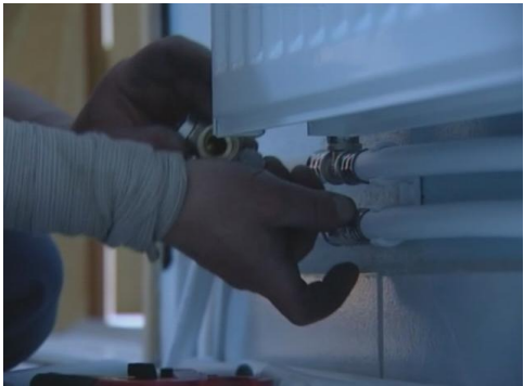
Resim 4.63: Bağlantı yönünün ayarlanması
