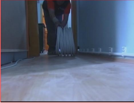
Resim 4.45: Borunun serilmesi
