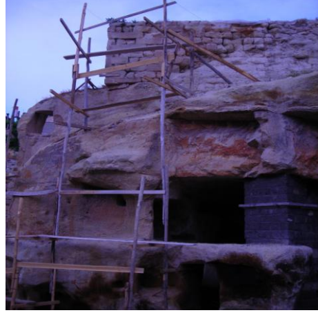
Resim 3.5:Yerleşim kesit fotoğrafı
