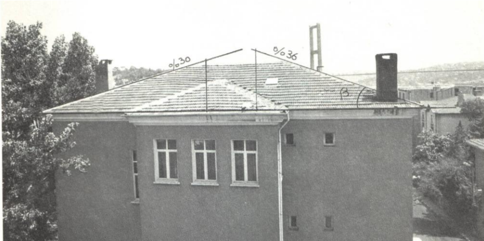
Resim 3.6: Çatı eğim ve yüksekliğinin fotoğraf üzerinde bulunması
