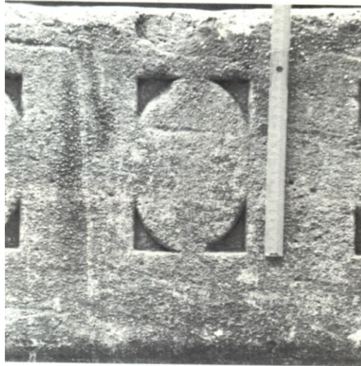
Resim 4.11: Detay fotoğraflarına koyulan metreden ölçü bulunması
