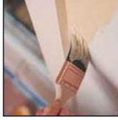
Şekil 2.21: Küçük yüzeylerin fırça ile boyanması
