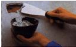
Şekil 2.17: Yüzey hazırlığına başlama (eski boyanın kazınip macunlanması)
