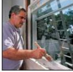
Şekil 2.24: Ahşabın astarlanması
