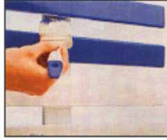
Şekil 2.25: Örtücü son kat boya uygulaması
