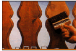
Şekil 2.26: Son kat olarak vernik uygulaması
